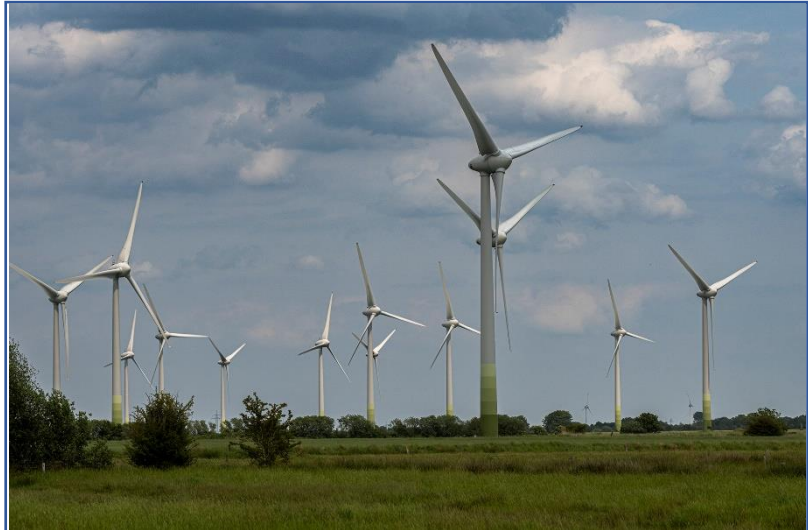
Wind ist gut, aber es braucht auch Speicher, gerade auch in Wärmenetzen
